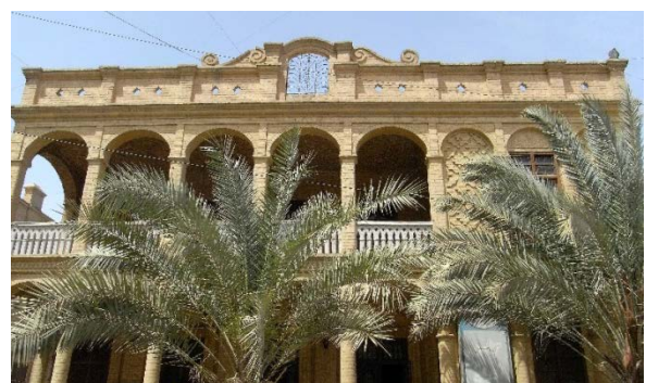
Above : Première municipalité moderne sous mandat britannique: immeuble de la "baladiya" (1931) ; Below : Eclectisme et métissage architectural. Maison al-Zahir, 1930.
