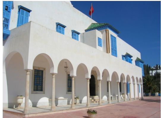
Dar Nejma Ezzahra (Sidi Bou Saïd, Tunisie), propriété du Baron Rodolphe d'Erlanger, architecte inconnu, 1912-1922.
